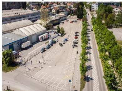
Kranjčeva ulica 112 parkirnih mest
